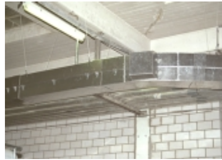
Schalldämmung Rohrleitung
