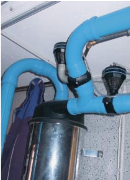
Abb. 8: Die Regelventile sollen nicht in der Nähe von Bögen montiert sein, sondern nach einer Beruhigungsstrecke von mindestens 3 d ( d = Durchmesser der Leitung).
