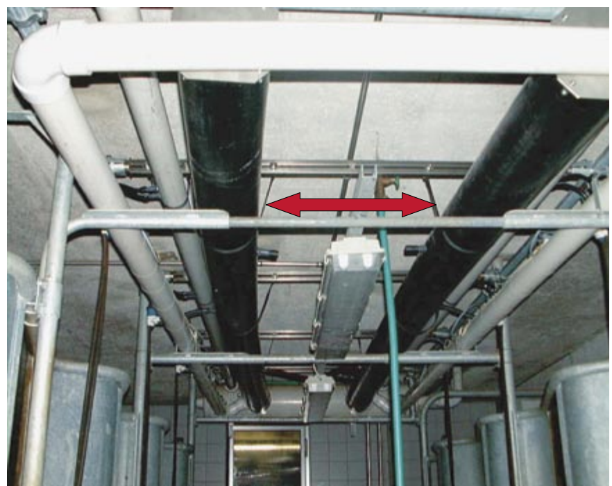
Abb. 4: Speziell eingebaute Puffertanks zwischen Luftleitung und Pulsatoren.
