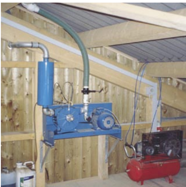
Abb. 6: Durch die Holzkonstruktion übertragen sich die Schwingungen und Vibrationen von der Vakuumpumpe auf das Gerüst des Melkstandes und somit auf das gesamte Melksystem.
