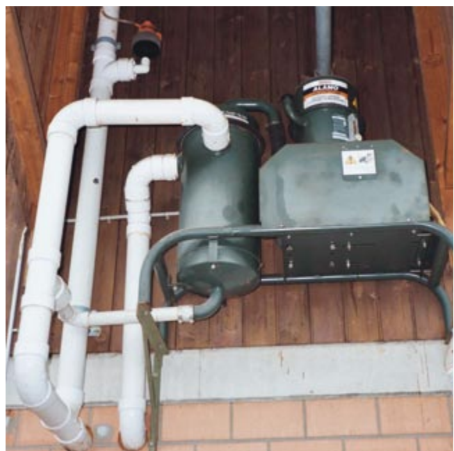
Abb. 7: Querschnittveränderungen und 90°-Bogen verursachen im Leitungssystem Wirbel im strömenden Medium und Druckveränderungen, die sich mit Schallgeschwindigkeit (330 m/s 2 ) retour bewegen.
